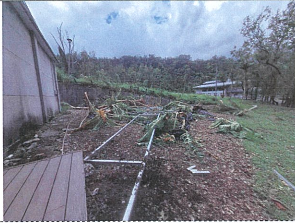
說明：楊柳風災侵襲(114.8.13)後原本的平台與芭蕉樹傾倒毀損
