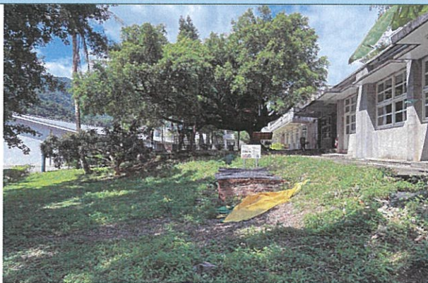
施工前：教室前方原本為兩座落葉推肥區（利用紅磚砌的約80公分的區域），周圍土石鬆動，遇到雨天會土石滑動，學生不易進入
