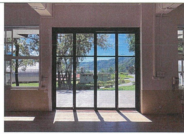
施工後：將窗戶拆除改為落地窗，視野向外延伸，甚至走出舞台區，可以往外一路延伸到美人山，令人心曠神怡
